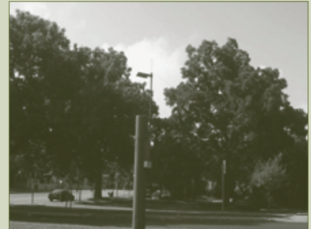
Hazard warning siren
