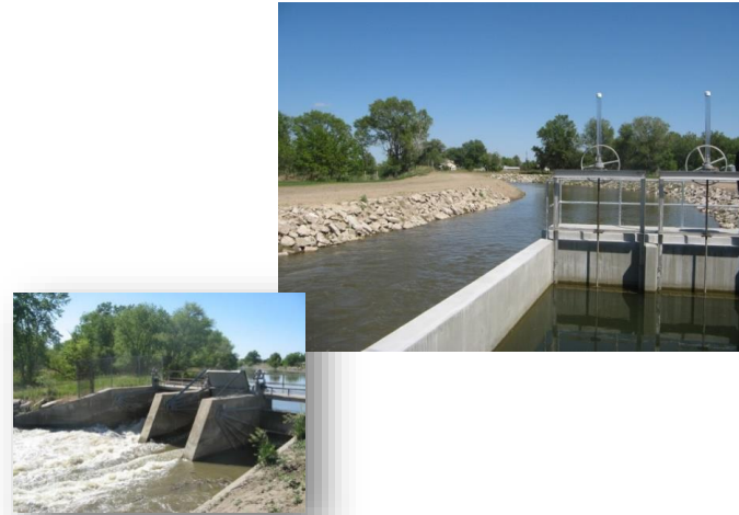
Cozad Canal, Gothenberg, NE
